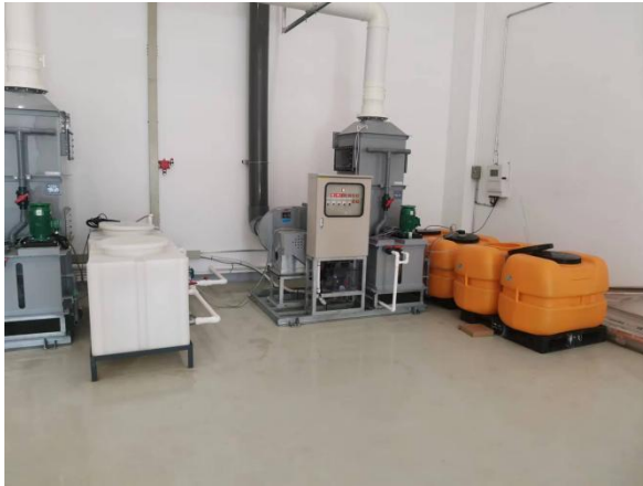
真空回流焊废气先经水喷淋处理的配套设施
