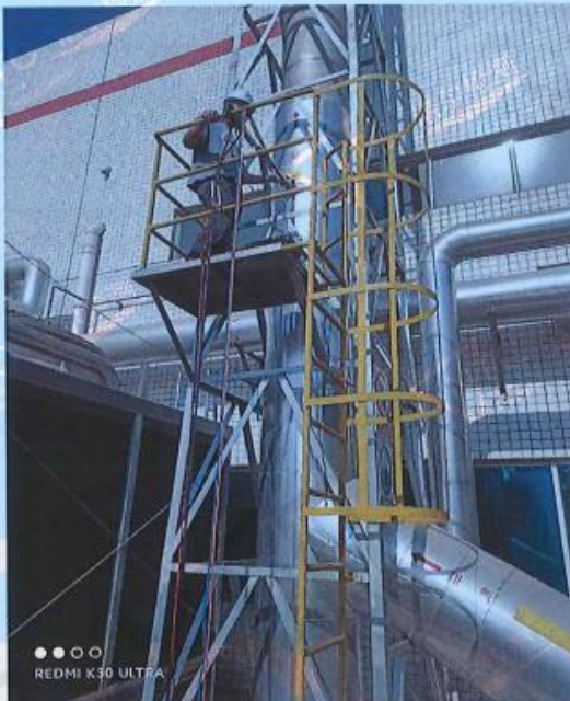
粉体清漆涂补废气处理后 CO 燃烧废气 排放口 (FS-15016-3)
